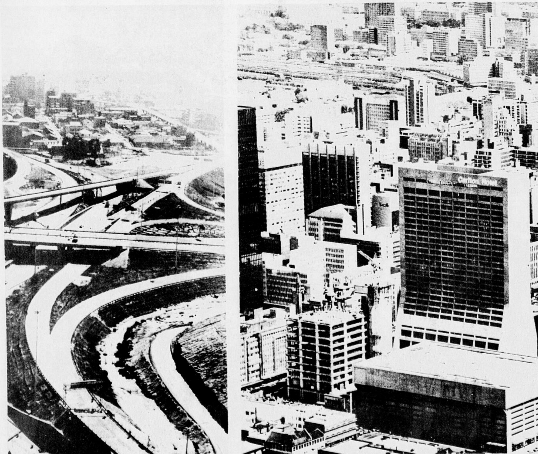
JOHANNESBURG — A gauche, la jonction routière de Heidelberg. A droite, l'hôtel et le centre commercial modernes de la ville, le Carlton Centre.
