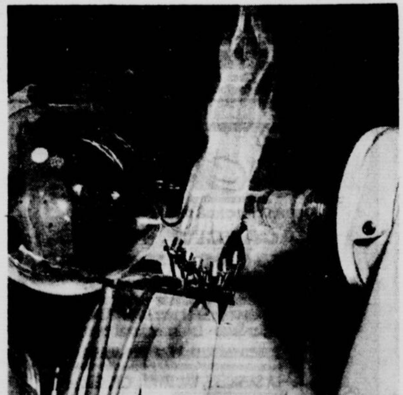
Le souffleur Ed Lister, qui est au Laboratoire Central de Recherches de McMasterville depuis 15 ans, met la dernière main à un large flacon soufflé sur son nouveau tour. La plupart des accessoires de verre du laboratoire sont fabriqués sur place.
