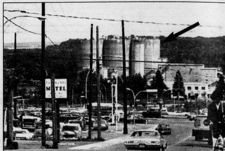
Le casino sera construit à l'endroit où se trouvaient encore, en 1972, les immenses silos de Canada Ciment vue de la rue Saint-Raymond juste avant le début des travaux.
