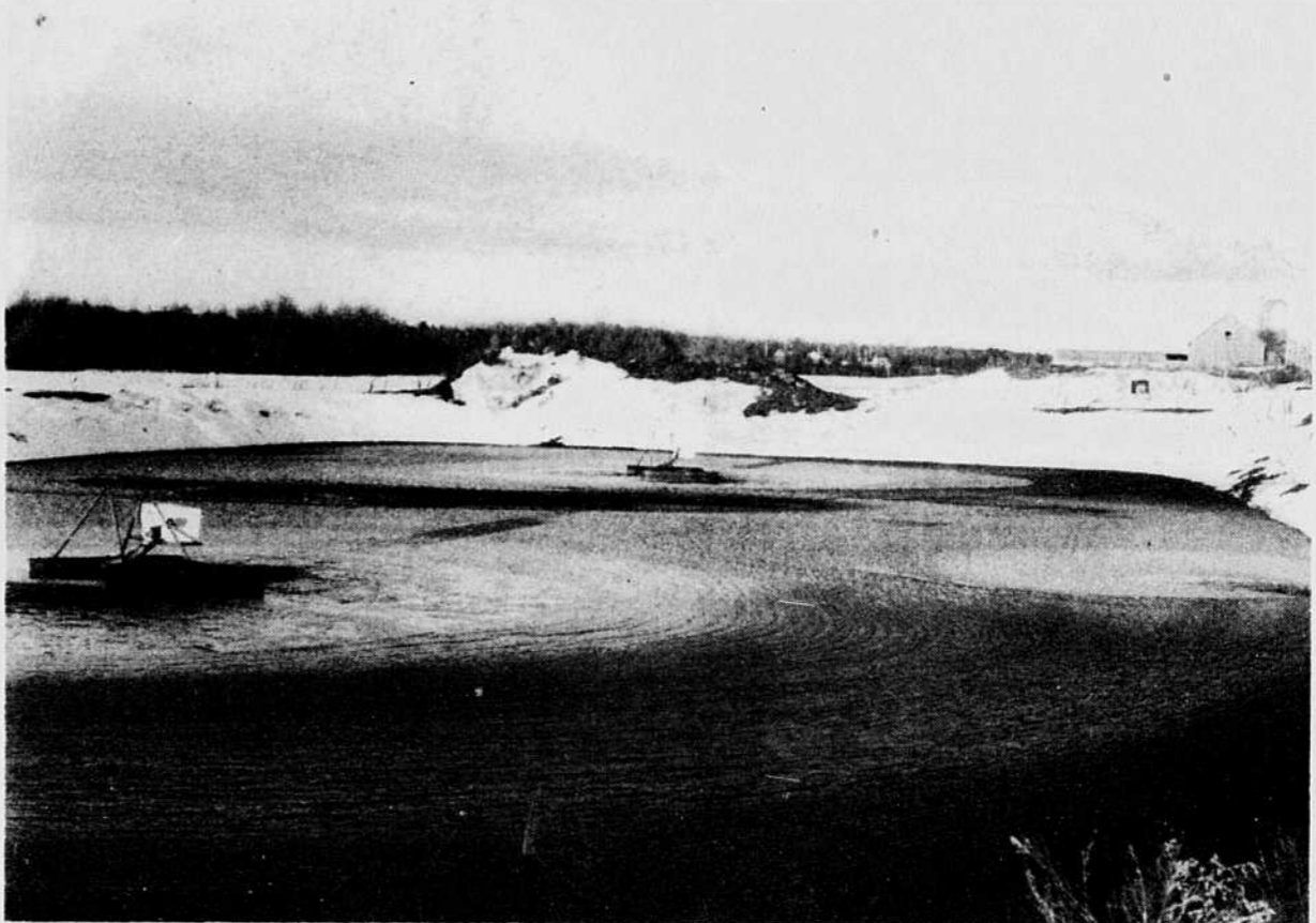
Le fumier liquide est aéré dans cet étang avant d'être retourné dans la vacherie, pour nettoyer les allées.
