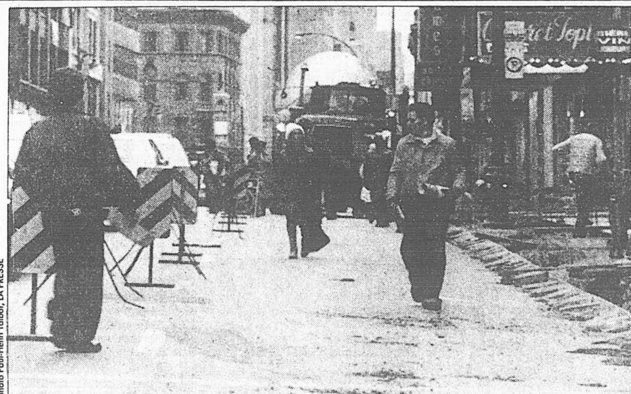
Les travaux dans les rues
