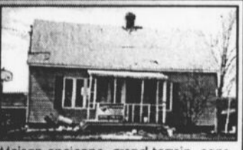
Maison ancienne, grand terrain, construction pièces sur pièces, petite étable, ruisseau.
