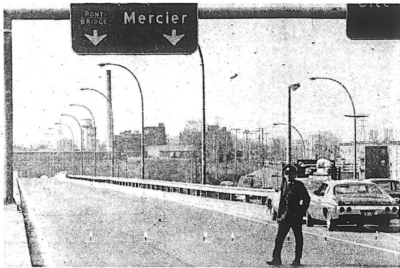
Des inconnus qui ont semé des clous sur le pont Mercier ont réussi à perturber considérablement la circulation, ce matin, et il a fallu fermer le pont pour permettre aux employés de la voirie de dégager la chaussée.
