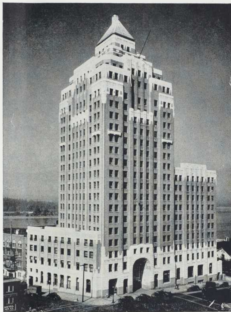
Edifice Marine, Vancouver, C.A. Installation faite en 1930.
