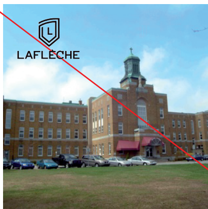
La marge de dégagement n'est pas respectée.
