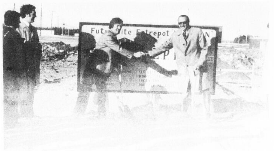
La levée de la première pelletée de terre sur le chantier de construction.
