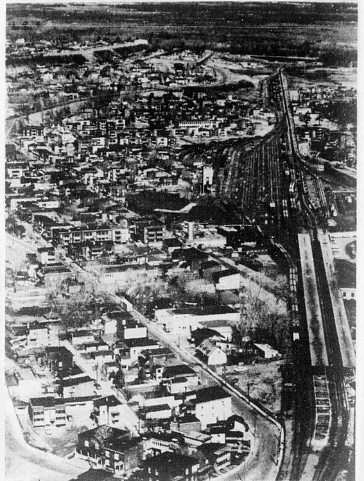
VUE AERIENNE de la cour de triage. L'autoroute passera juste à côté, livrant ainsi à la démolition 180 logements en excellent état.
