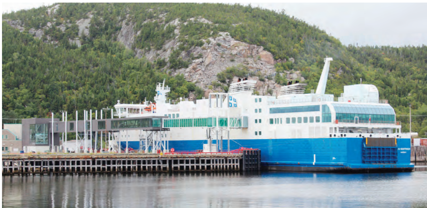
L'huile n'en finit plus de fuiter en provenance des joints d'étanchéité des propulseurs du F.-A.-Gauthier . La STQ doit de nouveau l'envoyer en cale sèche.
