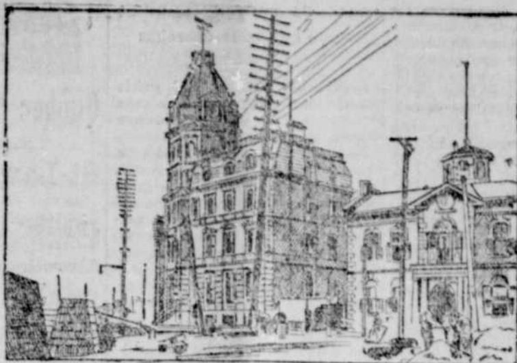
L'EDIFICE DE LA COMMISSION DU PORT DE MONTREAL. Montrant l'élargissement de la rue des Communes et une partie du nouveau mur de revêtement.
