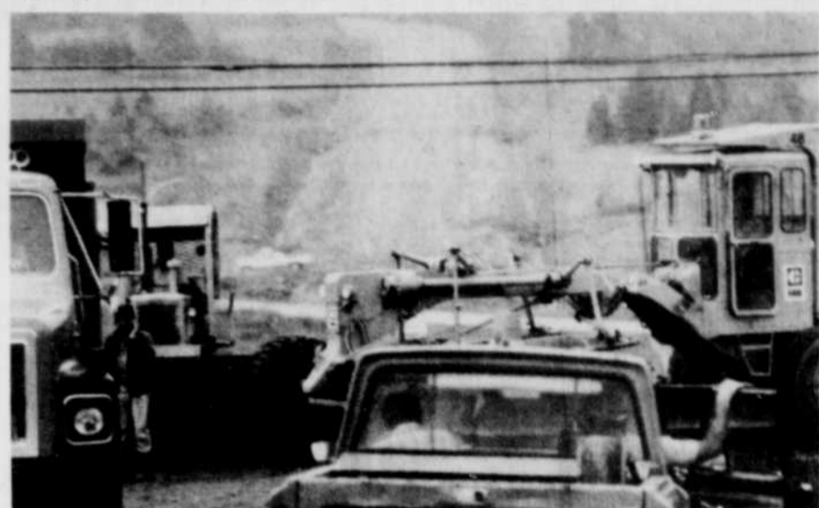
Même si les travaux sont presque terminés, les automobilistes devront patienter encore une année avant que la route 210 ne soit recouverte d'une couche de béton bitumineux.
