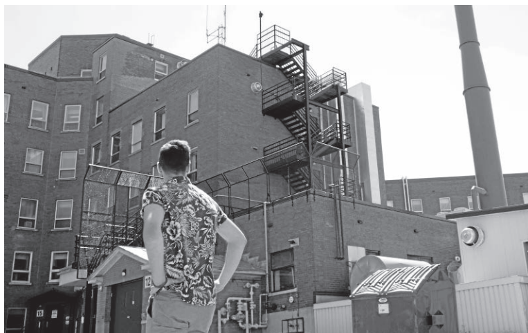
Plusieurs escaliers extérieurs sont installés à l'arrière du Centre Laflèche. — PHOTO: SYLVAIN MAYER
