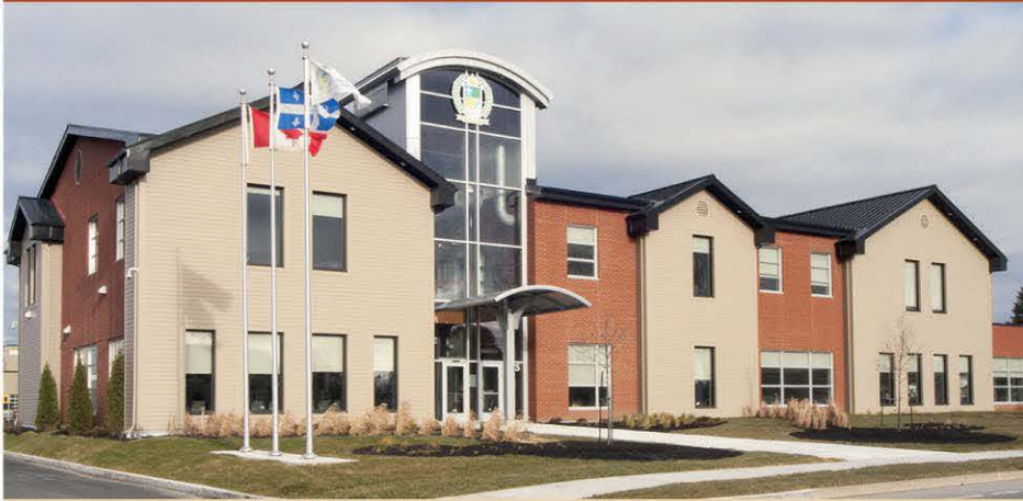
Une somme de 1 301 423 $ sera investie par la Ville pour l'installation d'un toit sur dalle de béton utilisable durant les quatre saisons de l'année au parc le Rocher.
