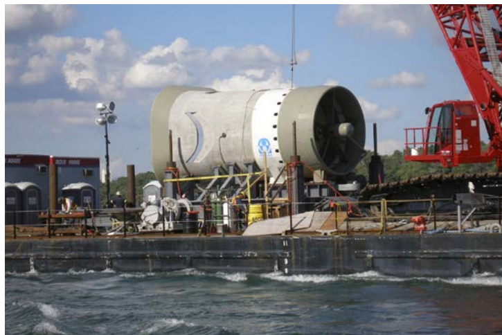
Ci-contre : Installation de l'hydrolienne de RER Hydro dans le Saint-Laurent, à la hauteur du Vieux-Port de Montréal.
