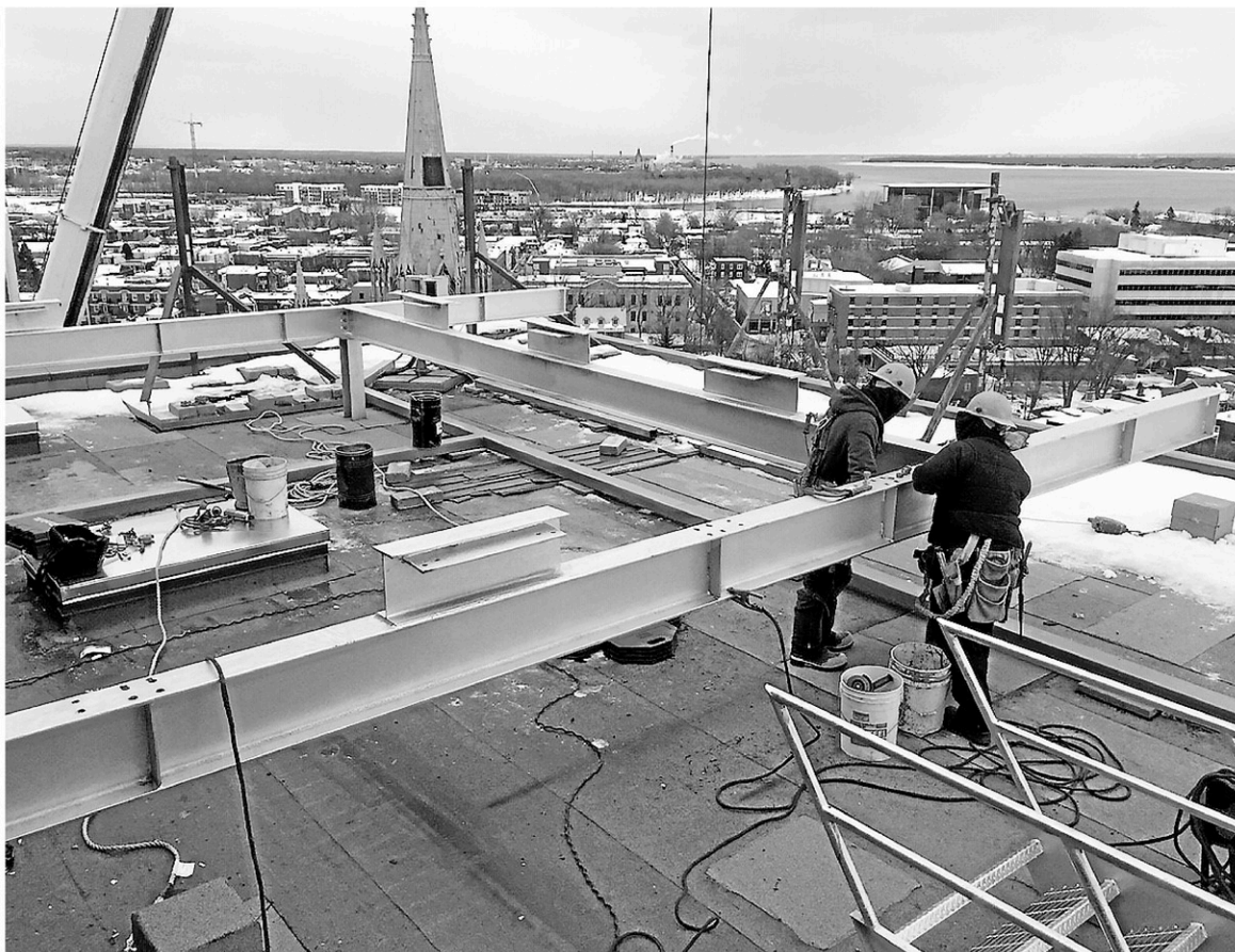
Des travaux ont eu lieu sur le toit de Place Royale pour changer complètement la tour d'eau. — PHOTO COURTOISIE
