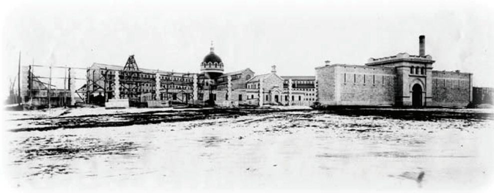
Prison de bordeaux en construction , circa 1010, source BAnQ, fonds Robert-Prévost
