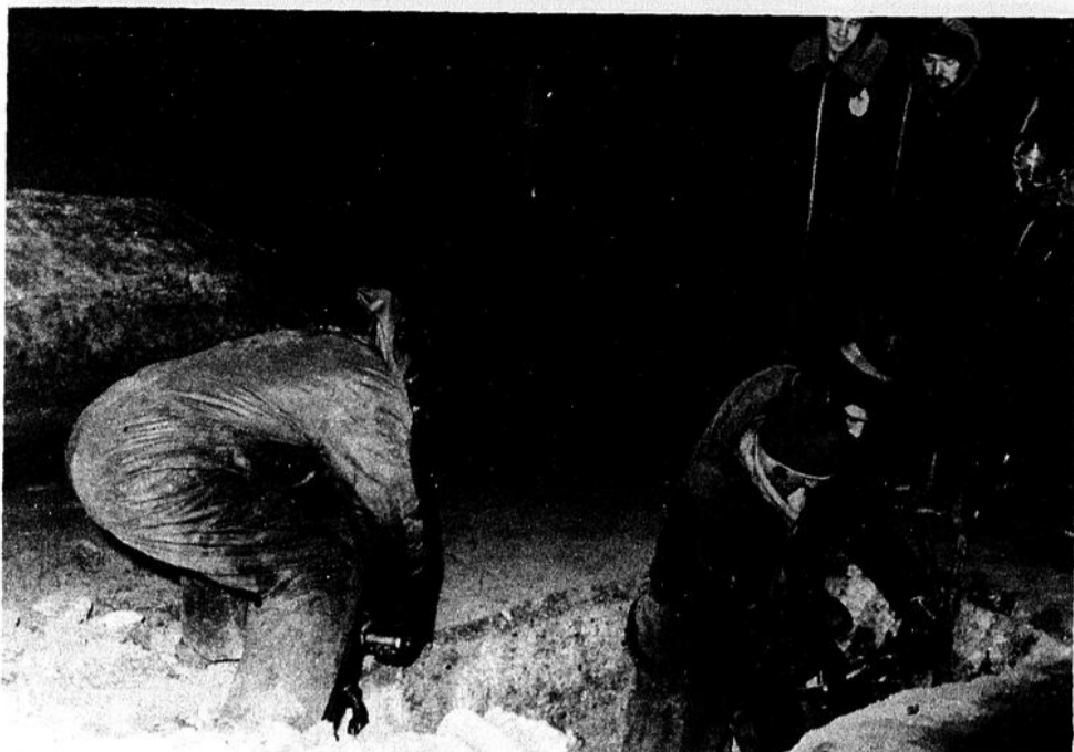
VERS LES PROFONDEURS. — Un conduit d'aqueduc s'étant avéré défectueux, les employés de la Voirie municipale de Cap St-Ignace prodèrèrent donc dimanche aux réparations qui s'imposaient. Cette photo fut prise vers 10.30 hres P.M. dimanche, alors que les hommes travaillaient sans arrêt depuis plus de 13 heures.
