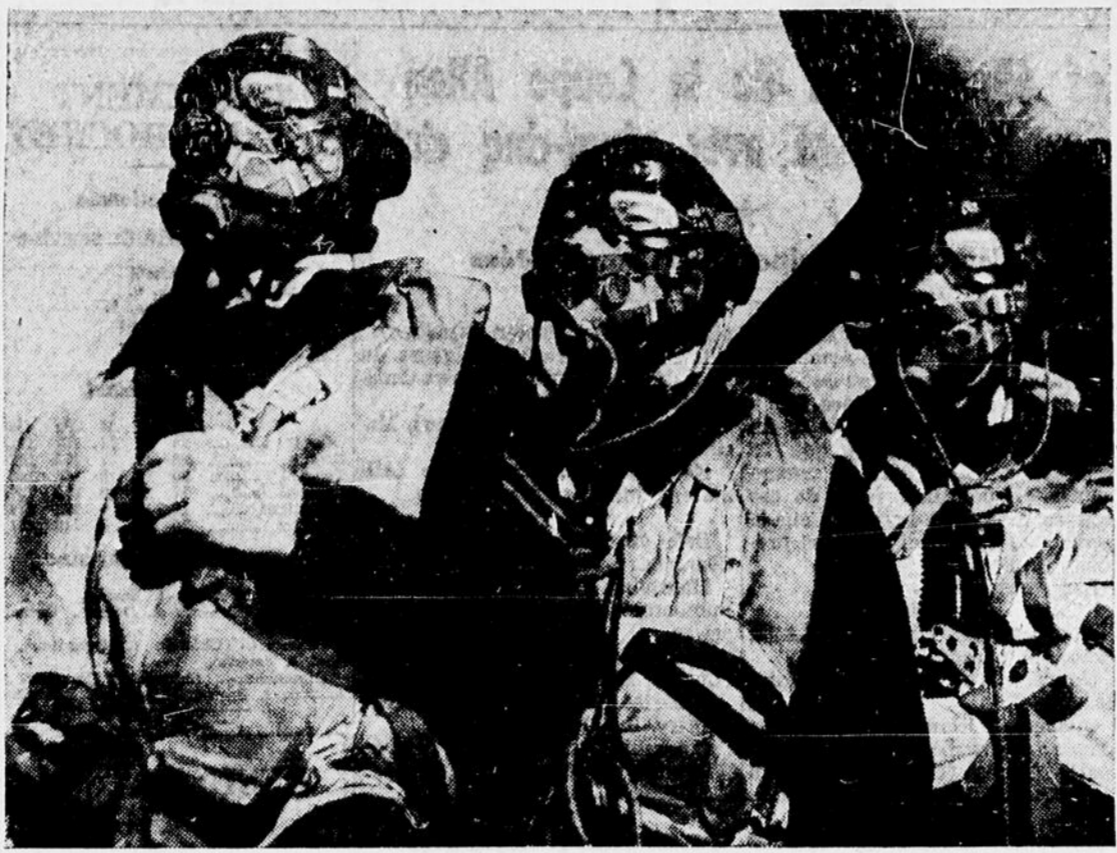
On dirait des épouvantails! C'est en réalité l'accoutrement que doivent porter les pilotes du Corps d'aviation royal canadien à une hauteur de 40 000 pieds. Les avions de chasse sont parfois appelés à voler à très grande altitude. Un de nos pilotes du Moyen Orient a même dû récemment s'élever jusqu'à 50 000 pieds, soit neuf milles au-dessus du sol, pour descendre un Messerschmitt allemand de type spécial. Le trio ci-dessus se compose du sergent de section R. FULLER, de Hortonville (N.E.), du lieutenant de section J. G. KELTIE, d'Edmonton (Alta), et de l'officier pilote J. JOHNSON, de Selkirk (Sask.) (Photo du C.A.R.C.)
