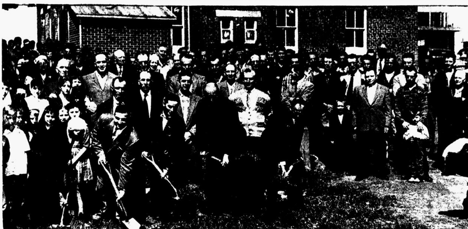
► NOUVELLE ECOLE A SHERRINGTON. — La cérémonie traditionnelle de la première pelletée de terre marquait l'inauguration des travaux de construction d'une nouvelle école à Sherrington, récemment. Sur la photo, parmi un groupe de citoyens, on peut voir M. l'abbé Philippe MARTIN, curé; M. Armand GREER, président de la Commission scolaire; S. H. le maire Joseph BOYER; M. Hercule RIENDEAU, député de Napierville; MM. les commissaires Marcel ROBIDOUX, Aldé BEAUDIN, François PROVOST; M. Paul CIRCE, secrétaire trésorier de la Commission Scolaire et M. Victor POISSANT, de Napierville, l'entrepreneur des travaux.
