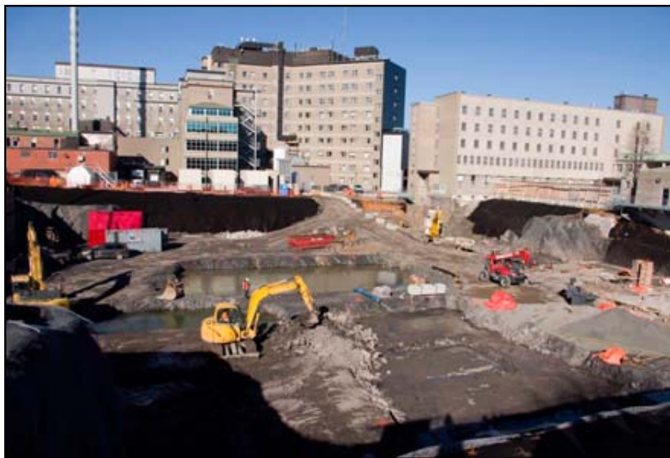
► La construction du Centre régional intégré de cancérologie à Lévis est l'un des facteurs permettant à Desjardins d'anticiper une croissance économique dans la région en 2017.
