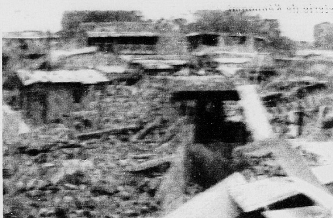
SEISME - Les premières photographies qui sont parvenues hier de la région de Maharashtra dans le sud-ouest de l'Inde montrent bien les dégâts causés par la force du séisme qui a atteint 6,4 sur l'échelle de Richter.
