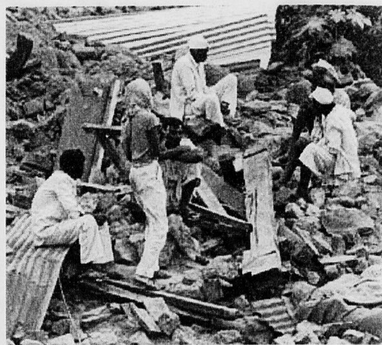
DEBRIS - La force de frappe du séisme a été telle que les maisons du village de Maharashtra se sont totalement effondrées. Des habitants du secteur fouillent dans les débris.
