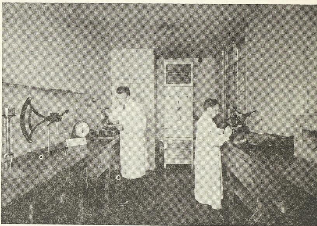
Salle à atmosphère conditionnée pour l'étude des cartons et papiers
