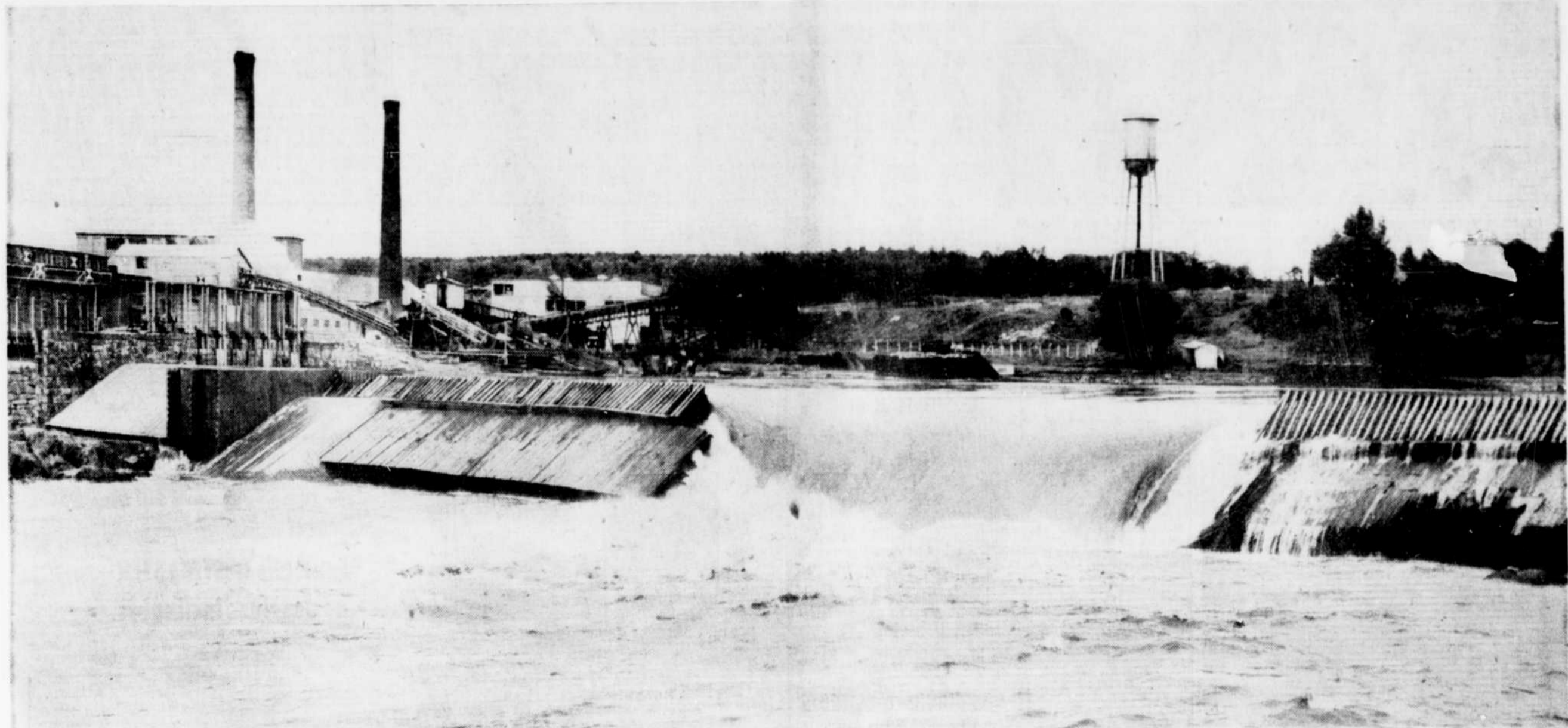
L'eau devient maître. — Sur cette photo l'on aperçoit le barrage de la Richmond Pulp and Paper, de Bromptonville, qui traverse la rivière St-François. Ce barrage a une longueur d'environ 700 pieds, et hier après-midi, une partie a cédé sous la forte pression de l'eau, on peut constater par la photo, que l'eau a endommagé environ 100 pieds de ce barrage. A la suite de ce bris, le niveau a baissé d'environ six pieds en sept heures. (Photo La Tribune)
