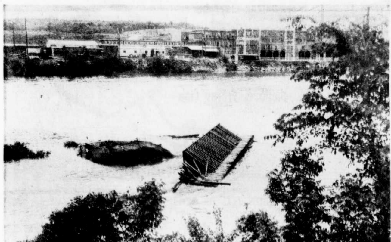
Petite promenade. — La photo du haut prise à Brompton après le bris du barrage de la Richmond Pulp and Paper nous montre une partie des débris du barrage qui a cédé sous la forte pression de l'eau. Le courant a trans-
