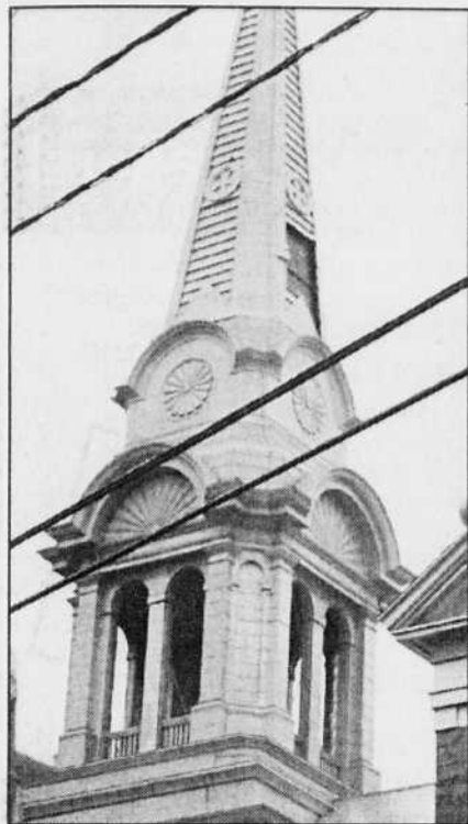
Le clocher de l'église St-Alphonse, au centre-ville de Thetford Mines, a été endommagé par les fortes bourrasques.
