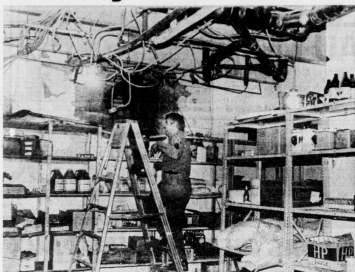
Des experts de l'Escouade des explosifs de la Sûreté du Québec examinent les lieux de l'explosion, survenue samedi matin, au sous-sol du restaurant Le Bordelais, à Chicoutimi.
