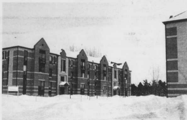
RÉSIDENTE - L'UQAC attend une réponse de la Société immobilière de l'Université du Québec d'ici à deux ou trois semaines, en vue de la construction d'une troisième résidence sur le campus de Chicoutimi. Si le projet est accepté, c'est à proximité des immeubles actuels que le chantier se mettra en branle dans les prochains mois.
