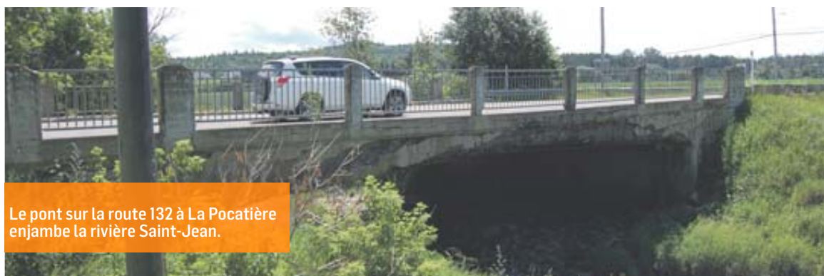
Le pont du Vieux Fronteau à Saint-Roch-des-Aulnaies traverse la rivière Ferrée.
