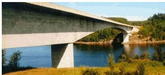
P-14679 Pont des Piles Construit en 1978 sur l'autoroute 55, au-dessus de la rivière Saint-Maurice, à Shawinigan
