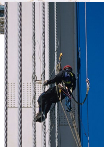
Inspection en appui sur cordes
