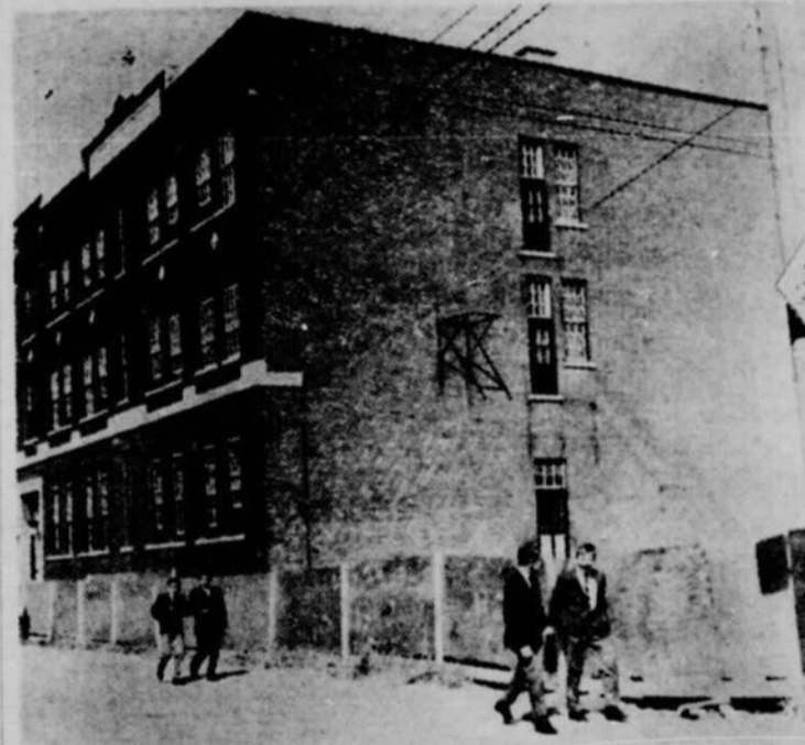
A la place de l'escalier de sauvetage, le vide !
