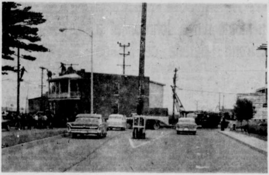
Déménagement — Située à l'angle des rues Marchand et Boulevard St-Joseph, cette maison a également dû laisser sa place pour permettre la continuation du boulevard. La maison de six logements sera installée rue St-Marc, sise non loin de son point de départ. On aperçoit ici la première phase du déménagement au cours de laquelle les employés de la compagnie de téléphone Bell s'affairent à enlever les fils électriques pour permettre le passage de la bâtisse.
