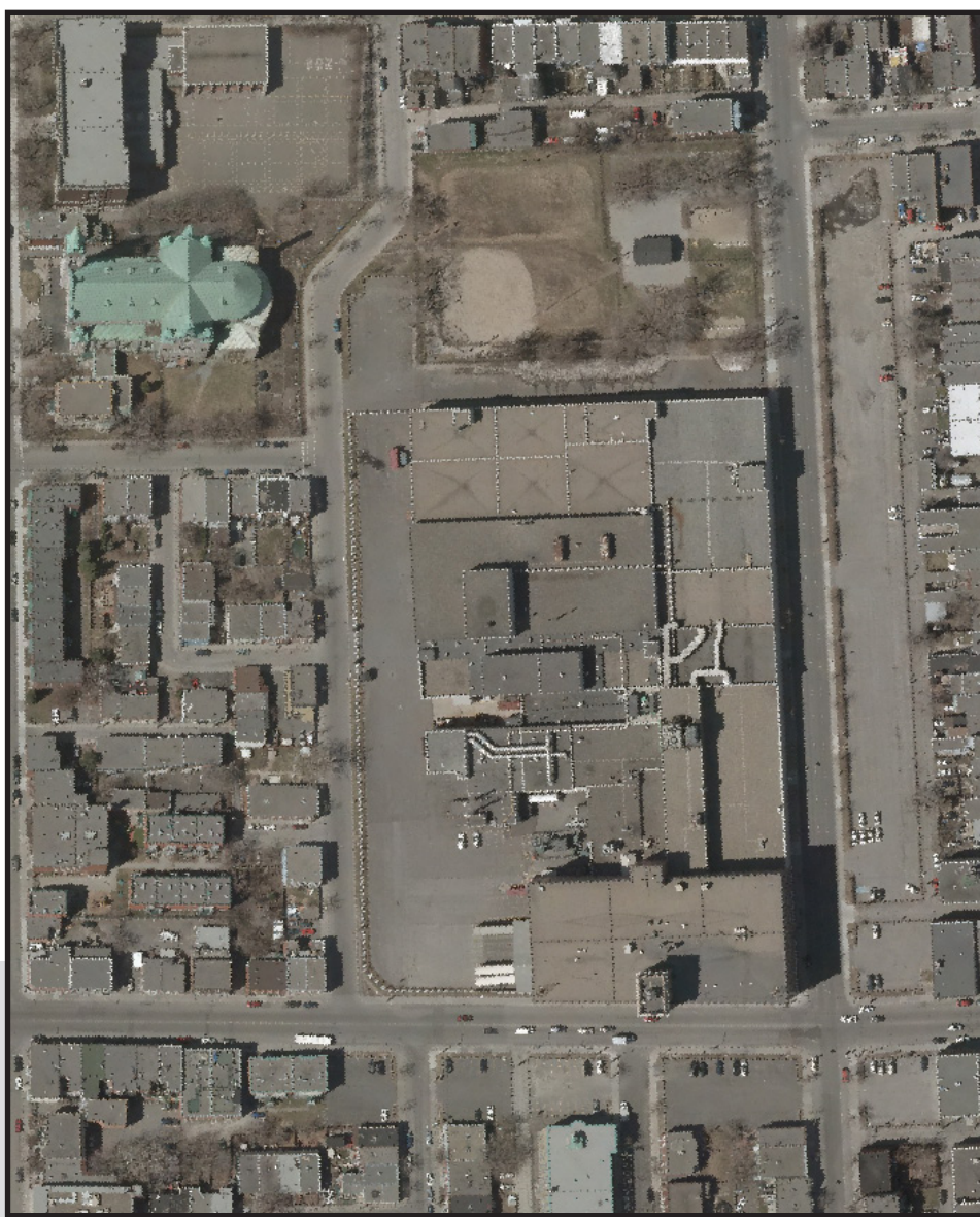
Photo aérienne – Secteur de la JTI-Macdonald
