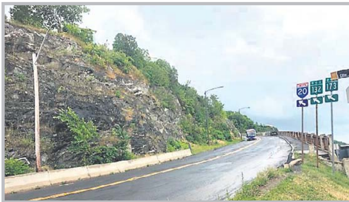
➤ Les travaux qui prennent place dans la côte Louis-Fréchette devraient s'échelonner jusqu'en décembre 2019.
