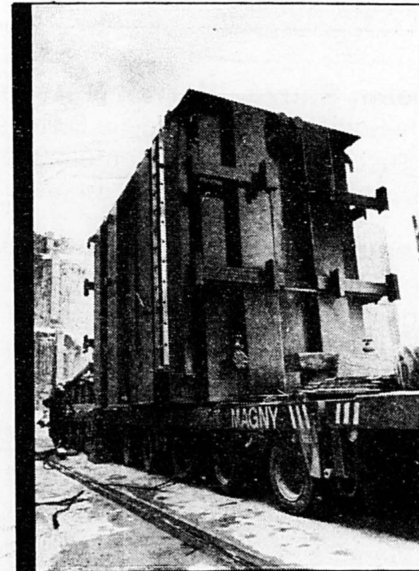
Livraison d'un transformateur géant.
