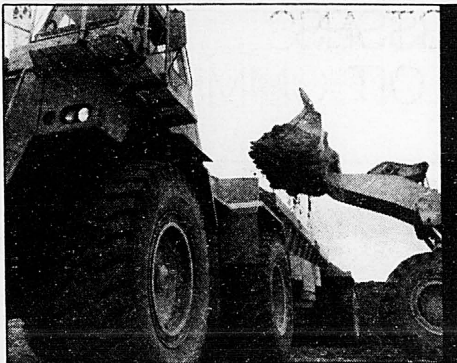
Des monstres de métal à l'échelle du chantier.
