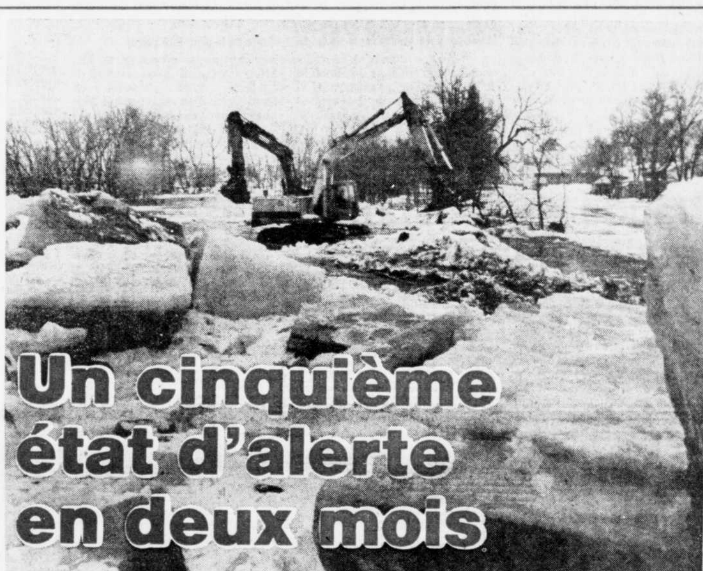
Les pelles mécaniques sont parvenues à ouvrir un nouveau passage pour l'eau, permettant au niveau de la rivière de baisser.
