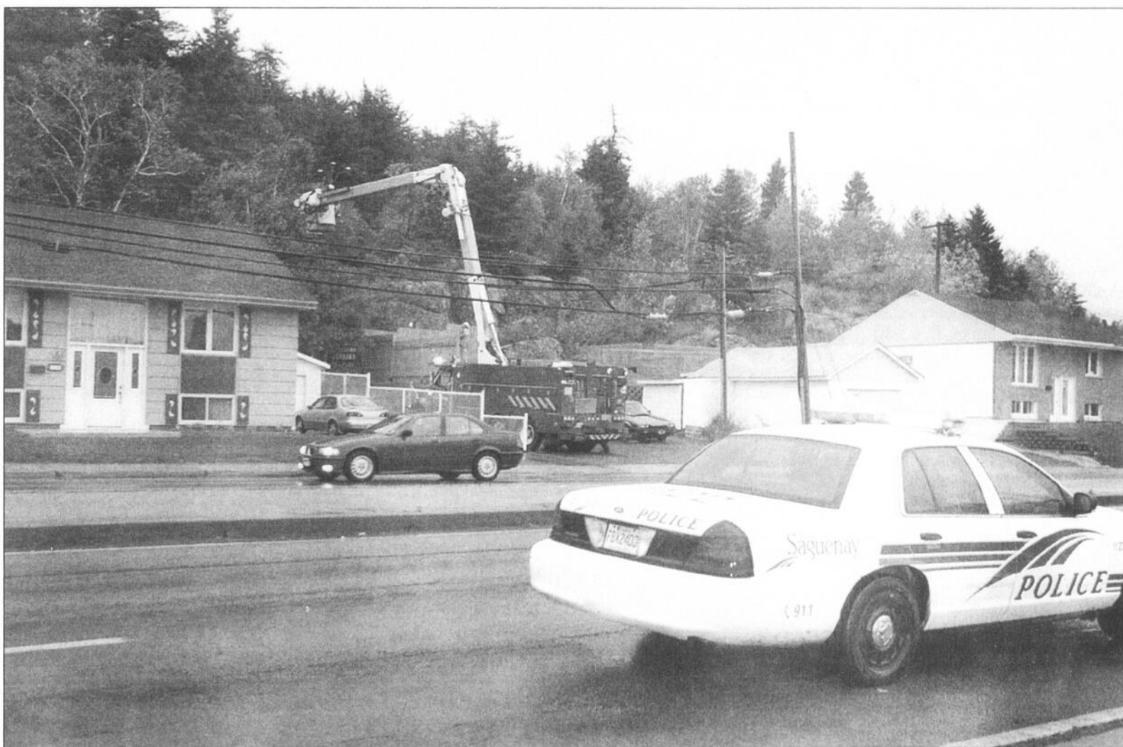
INCENDIE - La chute de fils électriques a provoqué un début d'incendie, hier après-midi, sur le boulevard Sainte-Geneviève à Chicoutimi.
