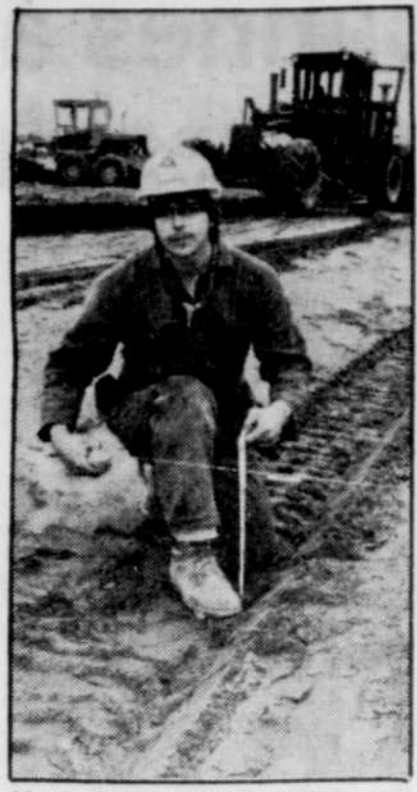
Marc Desruisseaux vérifie, au moyen d'un niveau et d'un ruban à mesurer, la profondeur du fossé qu'il creuse avec la niveleuse qu'on découvre à l'arrière.
