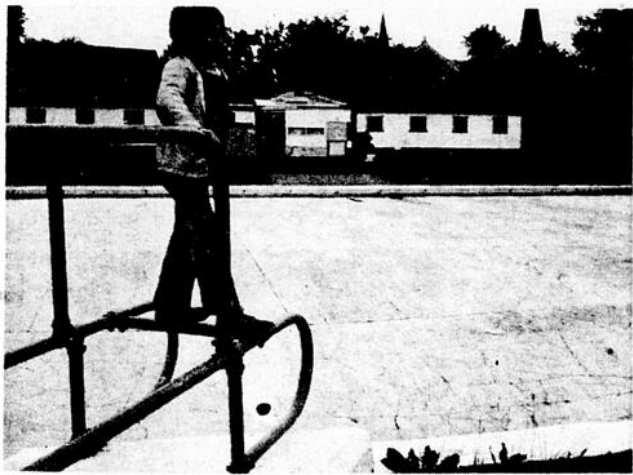
Le remblayage de la piscine municipale et la démolition de la bâtisse attenante mettront bientôt fin au danger constant que constitue ce lieu pour les enfants du voisinage. Ce jeune garçon, à l'instar d'un grand nombre qui l'ont fait avant lui, s'amuse ici sur la carcasse d'un plongeur à quelque 10 pieds au-dessus du fond de la piscine.
