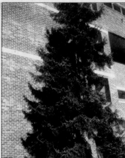
Même près des fondations, les épinettes ne causent aucun problème à moins qu'il y ait déjà des faiblesses dans la construction.
