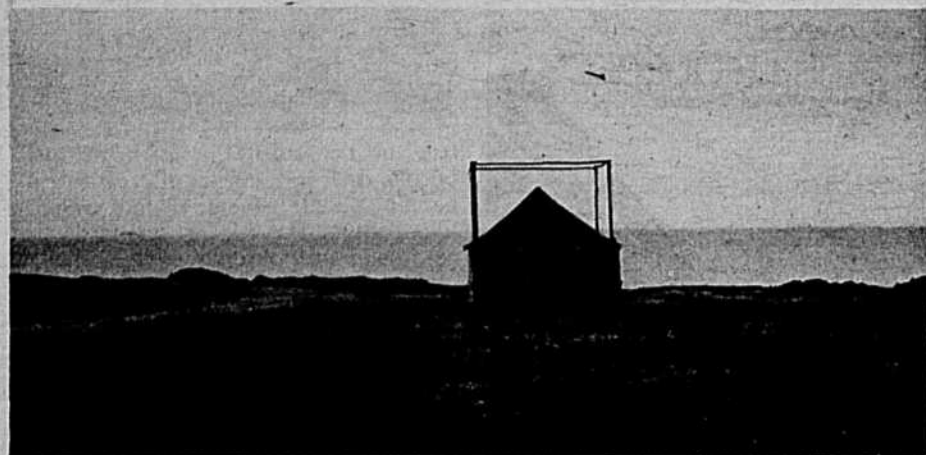
Pour l'entreposage de la récolte de foin, les Madelinots ont imaginé la baraque, une grange à toit montant.
