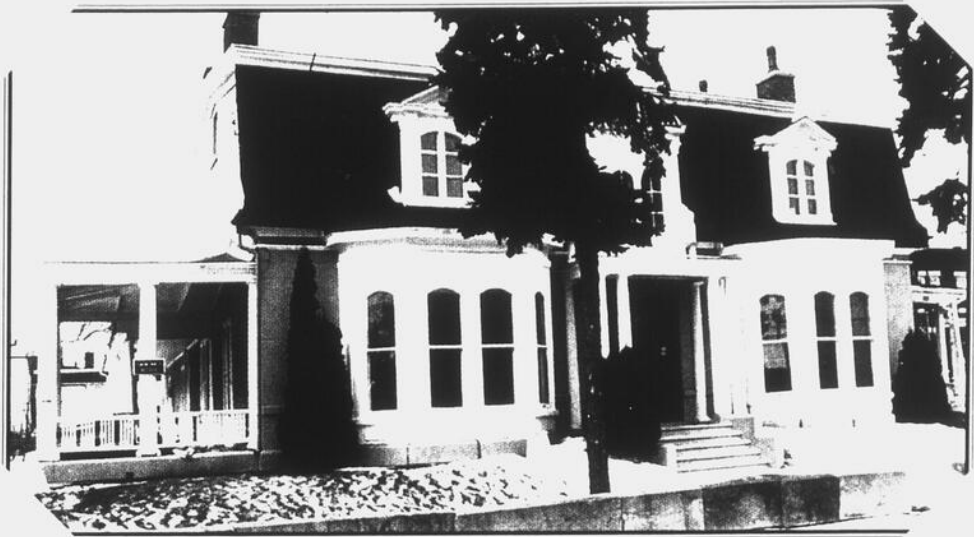
La Maison Macdonald, rue Jacques-Cartier Nord, a été la propriété de Duncan Macdonald, maire de Saint-Jean entre 1886 et 1889 et l'un des principaux actionnaires de la St John's Stone & Chinaware Co, la plus célèbre des usines de poterie et de céramique de la ville. On retrouve plusieurs pièces produites à cette usine au Musée de la Place du Marché.
