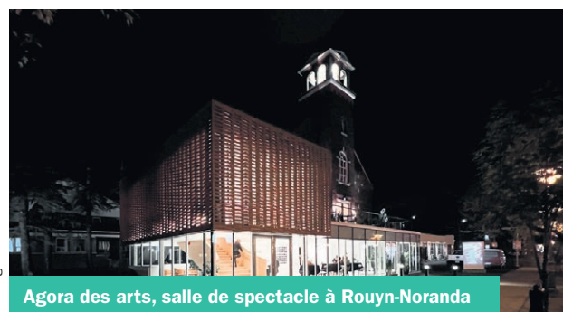
Transformation de l'ancienne église Notre-Dame-de-Protection en salle de spectacle
