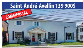
Saint-André-Avellin 139 900$ COMMERCIAL BÂTIMENT COMPRENANT 2 LOCAUX COMMERCIAUX ET 1 LOGEMENT RÉSIDENTIEL DE 2 CHAMBRES À COUCHER, AU CŒUR DU VILLAGE, SIA : 15650734 - SIMON
