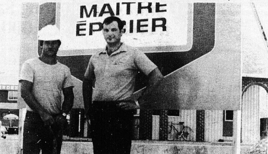
Deuxième "première pelletée de terre" pour les Galeries Berthier, vendredi dernier. Sur la photo, MM. Richard Saint-Martin (de Germain Saint-Martin construction) et Serge Bédard.
