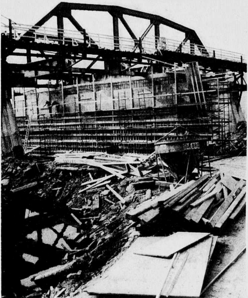
Tout ce qui reste de l'ancienne structure du pont Aylmer sera disparu le 18 septembre.
