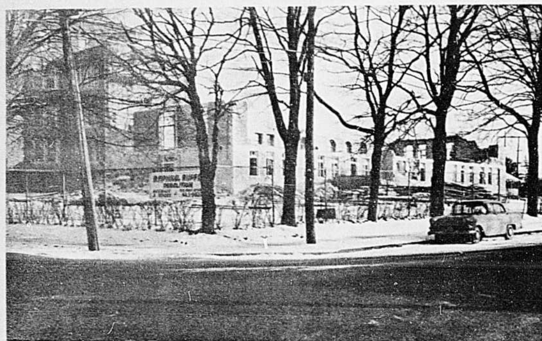
Le pic des démolisseurs continue son oeuvre. On voit ici où en sont les travaux de démolition de l'école normale de St-Jérôme. Dans quelques semaines ce sera chose du passé... mais il restera toutefois des souvenirs inoubliables.
