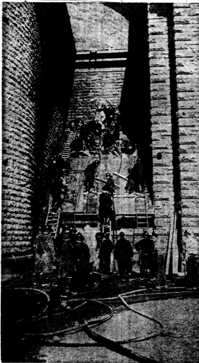
A L'ASSAUT DE LA TOITURE — C'est sous cette toiture que les flammes se frayaient un chemin vers le dôme lors de l'arrivée du premier contingent de pompiers. Des échelles ont été dressées en toute hâte pour permettre d'y percer des trous suffisamment grands pour y installer des boyaux. (Photo "Montréal-Matin", par David Bier)
