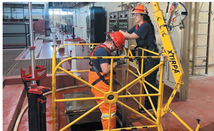
Des employés s'affairent à réparer une tige de vanne dans un bassin de traitement d'eau.
