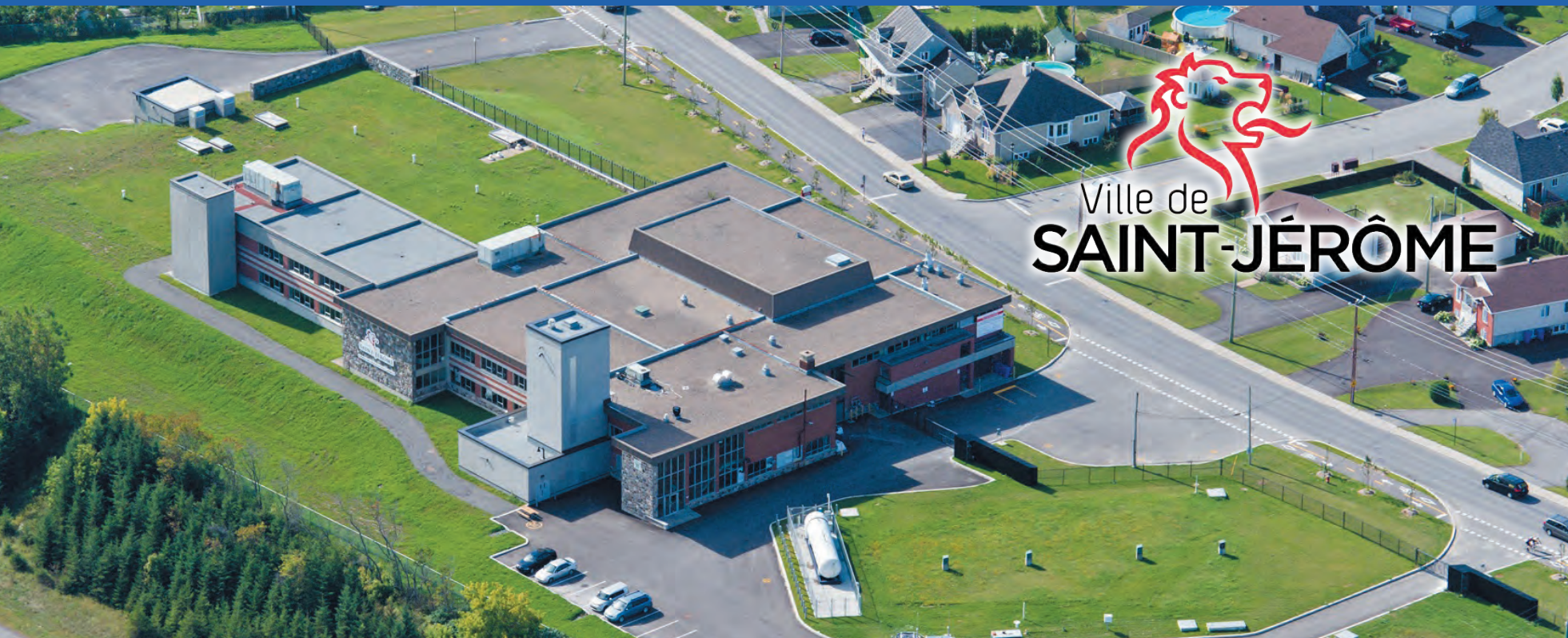
Station de production d'eau potable de Saint-Jérôme.
